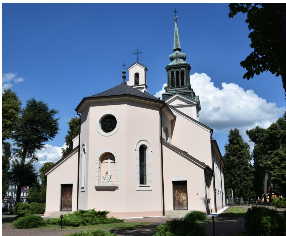
Fotografia 10. Widok na Kościół pw. Świętego Krzyża w Kozienicach, gm. Kozienice
