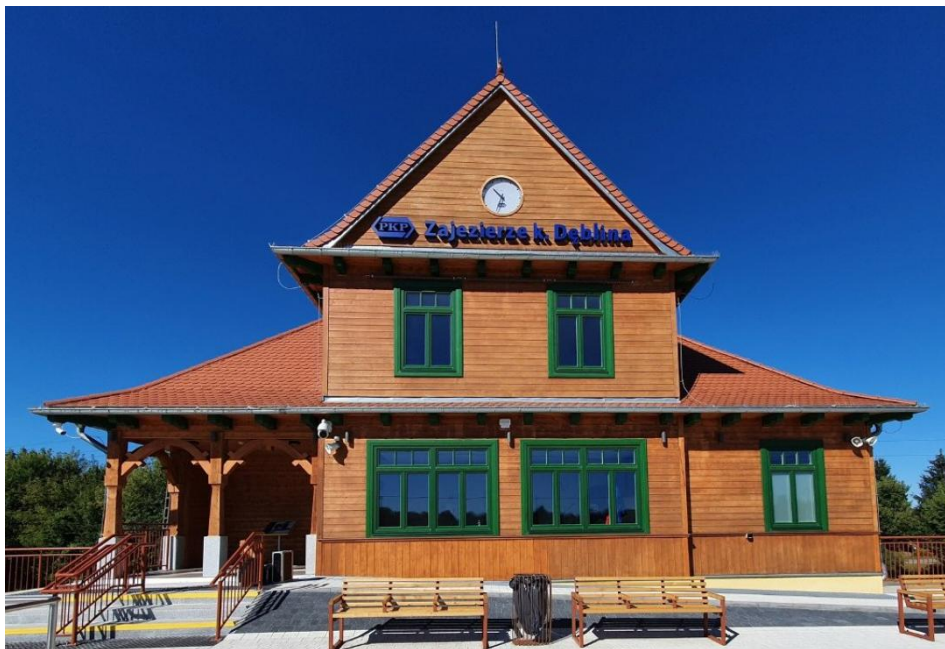
Fotografia 31. Widok na budynek dworca w Zajezerzu po przeprowadzonej rewitalizacji, gm. Sieciechów
