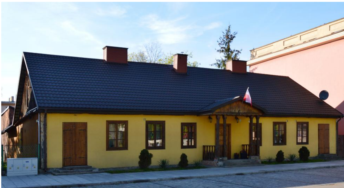
Fotografia 3. Drewniany budynek w stylu dworku mazowieckiego w Kozienicach (ob. przekształcony), gm. Kozienice
