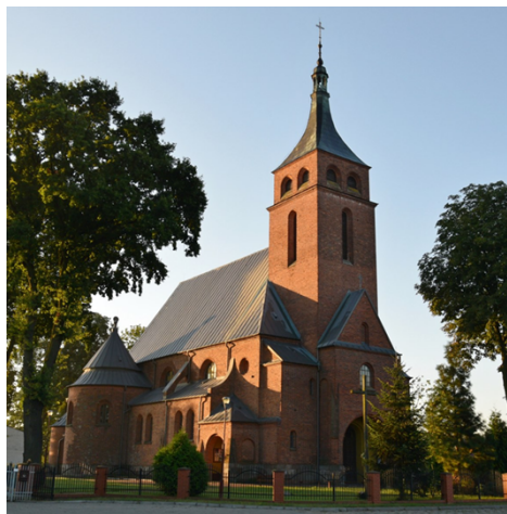
Fotografia . Kościół w Brzeźnicy, gm. Kozienice
