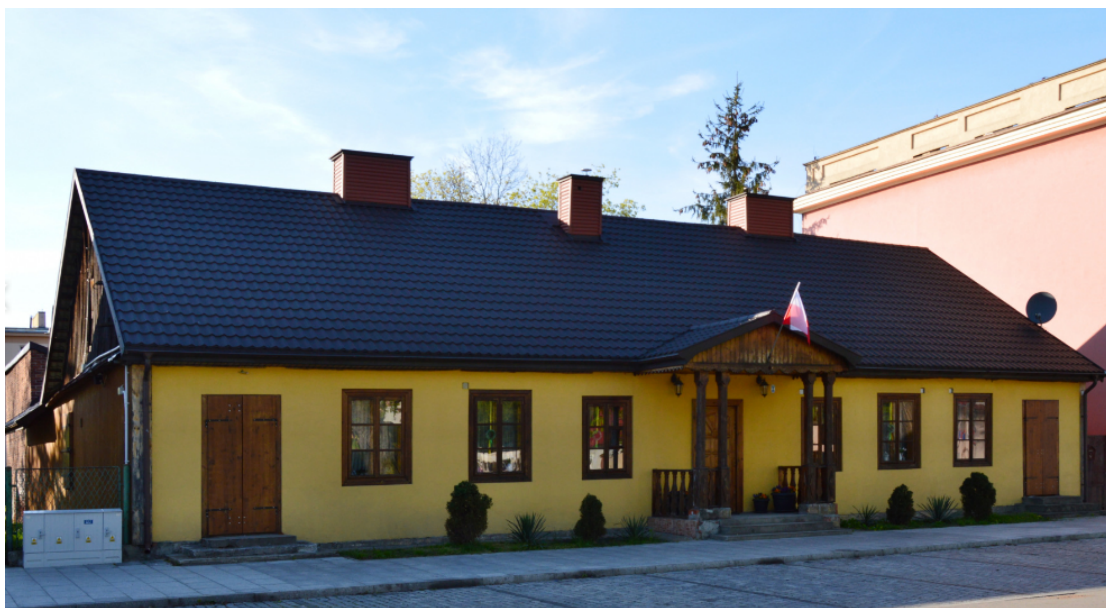
Fotografia . Drewniany budynek w stylu dworku mazowieckiego w Kozienicach (ob. przekształcony), gm. Kozienice
