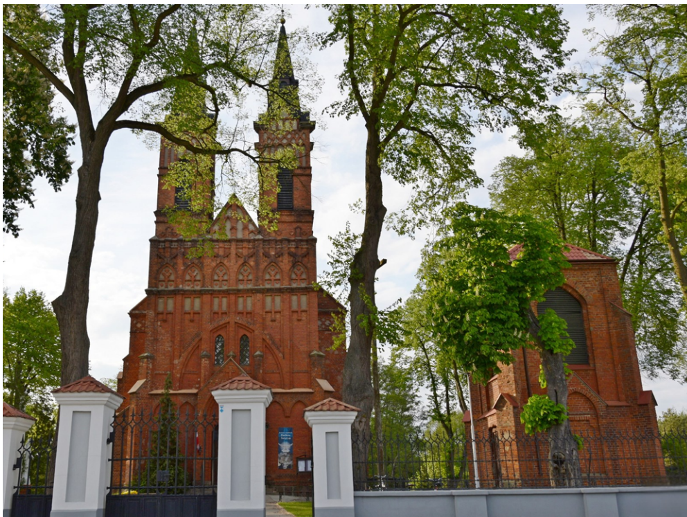
Fotografia . Widok na Kościół w Rozniszewie, gm. Rozniszew
