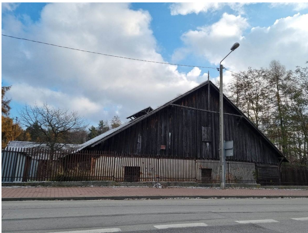
Fotografia . Widok na budynek Hamerni w Kozienicach, gm. Kozenice
