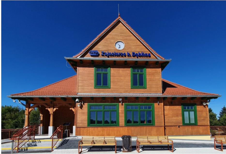
Fotografia . Widok na budynek dworca w Zajezierzu po przeprowadzonej rewitalizacji, gm. Sieciechów
