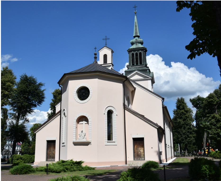
Fotografia . Widok na Kościół pw. Świętego Krzyża w Kozienicach, gm. Kozienice
